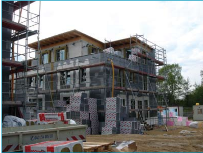
Best-practice aus Hamburg: Bau eines Passivhauses am Kornweg.
